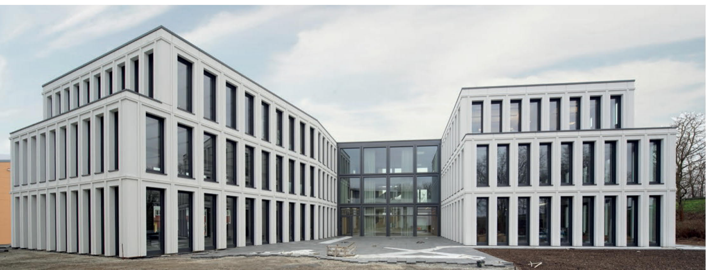
Photos: Dreifler Bau
