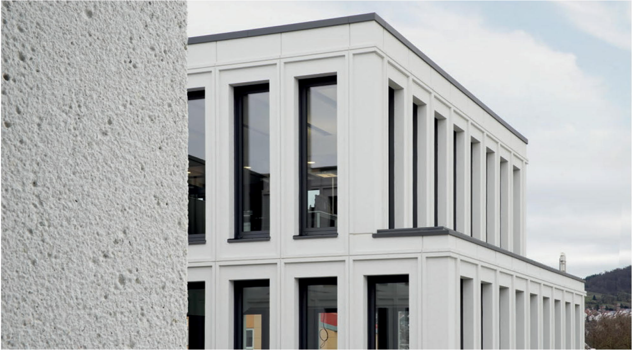
Helle Betonrezeptur und gestrahlte Oberfläche betonen den eleganten Charakter.
