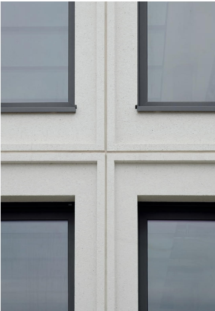
Die Vorsatzschale wird durch äußerst präzise Lisenen horizontal und vertikal gegliedert.
